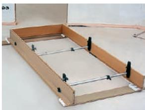
Positionner les écarteurs à la hauteur de la serrure de la porte et à la hauteur de la charnière inférieure.
