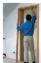
Une fois la colle durcie, couper l'excédent et retirer les serre-joint de cadre et les positionneurs de porte. Placer le contre-chambranle décoratif.
