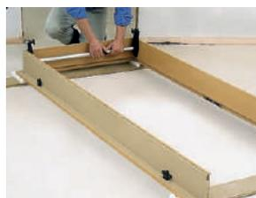
Placer le positionneur aux dimensions définies dans le chambranle afin que le tube se trouve au milieu de la profondeur.
