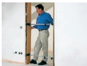
Insérer le cadre de porte dans la découpe du mur et sécuriser pour éviter tout basculement.
