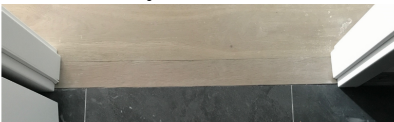
Porte ouverte avec changement de revêtement de sol
